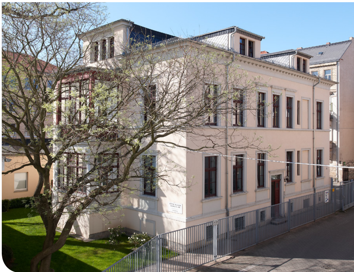
Verwaltungsgebäude Katharinenstraße administrative building in Katharinenstraße
