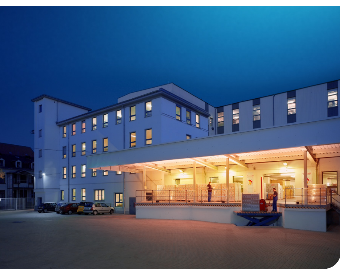
Produktionsgebäude Hofansicht production building, view from the courtyard
